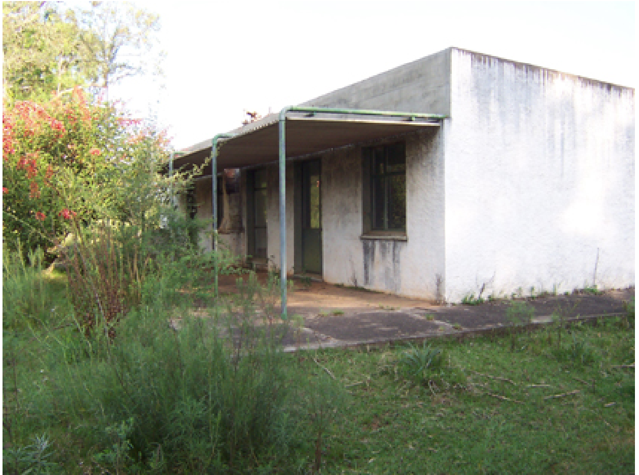
Escuela abandonada cerca de Tanqueras, Rivera
